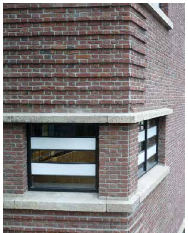
Detail gevel, bestaande gebouw
