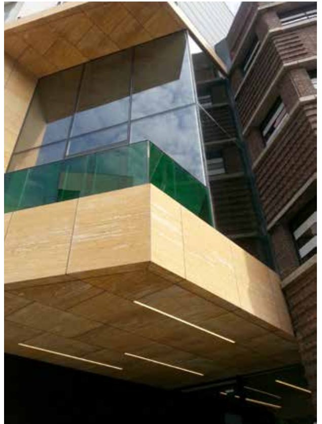
Uitbreiding gevel Kruiskade, toegang theater Uitkraging bestaande uit travertijn
